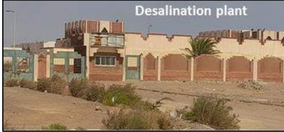
شكل رقم 78 محطة تحلية المياه
